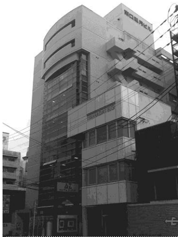
(写真) 東口鳳月ビル 6階にあります
